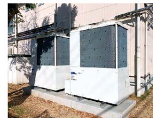
停電対応型GHP室外機
